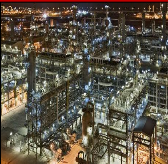
Ras Laffan Qatar Qatar Gas & Ras Gas LNG plants
